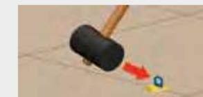
4 После полного высыхания клеевого раствора для удаления клина ударьте по верхней части зажима вдоль шва. Нижняя часть зажима остается под плиткой.
